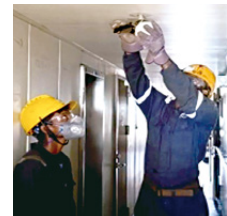
解撤前の船内有害物質除去作業
