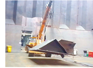
貨物倉内の解撤作業
