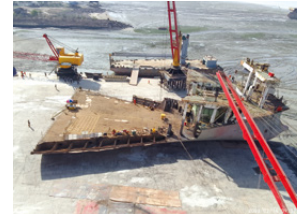
陸上へ引き上げての解撤作業
