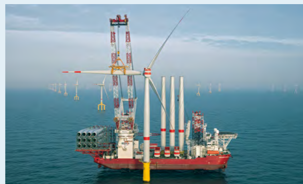
Seajacks社が保有・運航する世界最大級の洋上風力発電設備設置船
