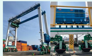
荷役機器の水素燃料電池への換装実証(横浜港)
