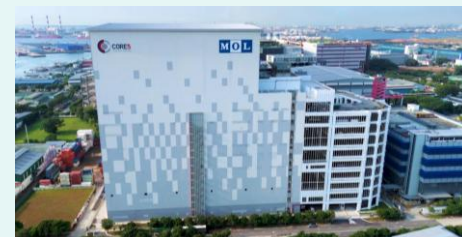
省エネ型冷凍冷蔵倉庫(シンガポール)
