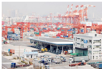
東京国際コンテナターミナル における太陽光発電システム
