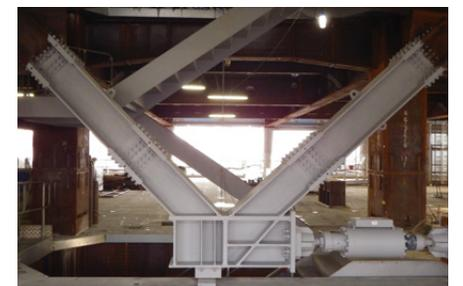
建設中の新ダイビルにおける制振装置
