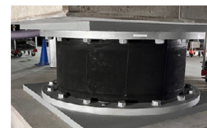
八重洲ダイビルの中間免震装置
