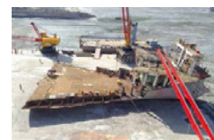
陸上へ引き上げての解撤作業
