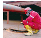
作業前のタンク内ガス検知作業
